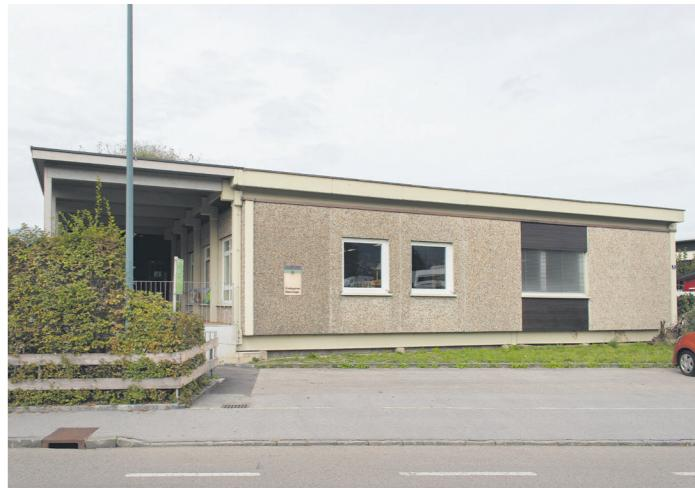
**DER PAVILLONARTIGE SYSTEMBAU** ist ein typisches Kind seiner Zeit. Er wurde 1972 aus Betonfertigteilen in Skelettbauweise errichtet.
