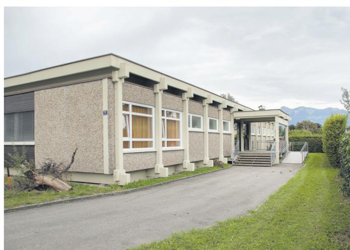
**DER KONSTRUKTIONSRASTER** der Betonfertigteile prägt auch die Fassaden.
