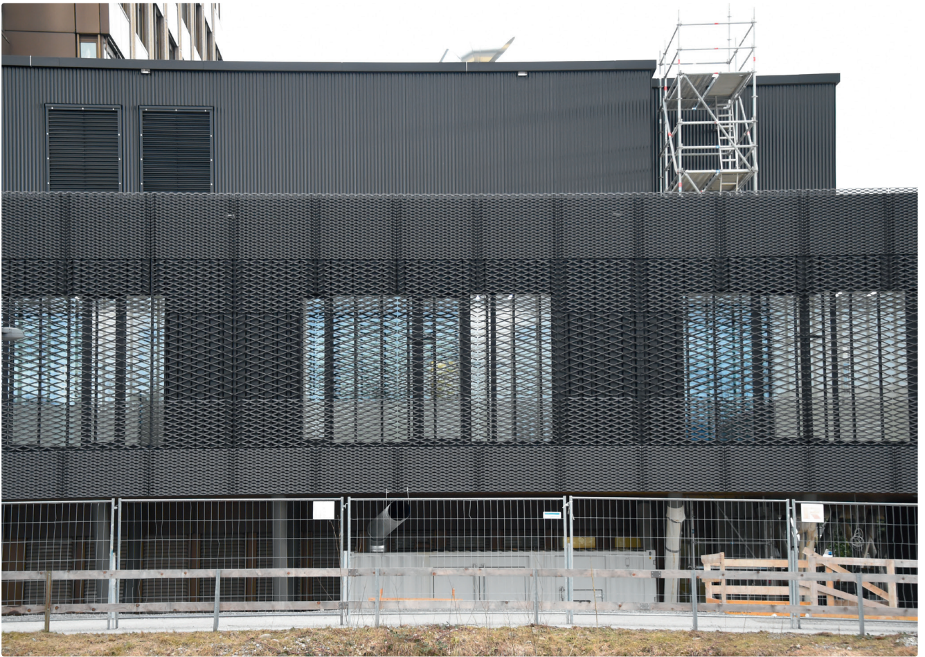
Die Maschenweite des Streckmetalls variiert und steuert damit Ein- und Ausblicke.
